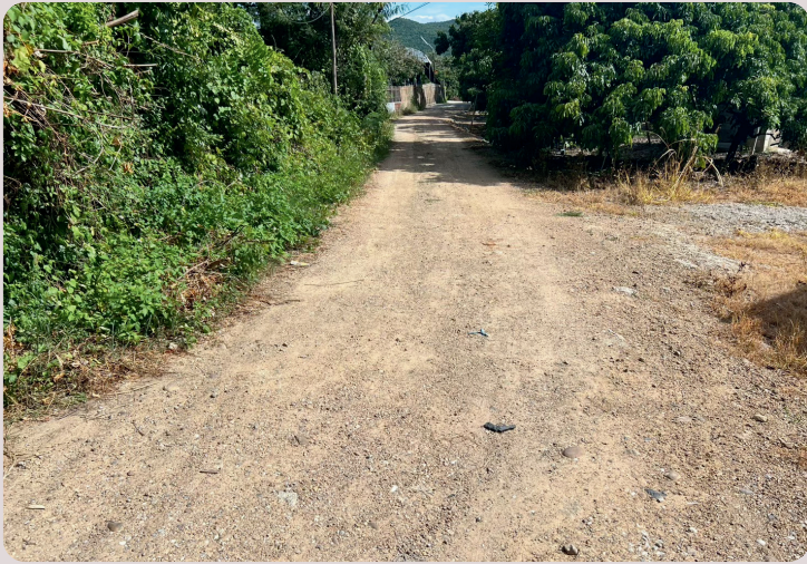
ก่อสร้างถนนคอนกรีตเสริมเหล็ก บ้านชาววัง หมู่ที่ 19
