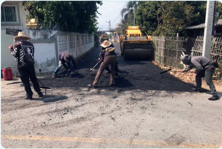
ปรับปรุงผิวจราจรแบบไอเวอร์เลย์ด้วยแอสฟัลติกคอนกรีต บ้านท่าหลุก หมู่ที่ 4
