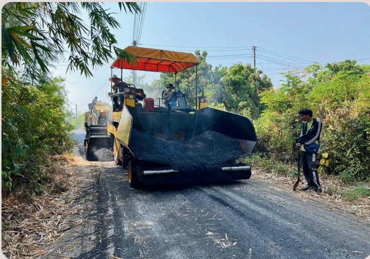
ปรับปรุงผิวจราจรแบบไอเวอร์เลย์ด้วยแอสฟัลติกคอนกรีต บ้านห้วยอีแต หมู่ที่ 13
