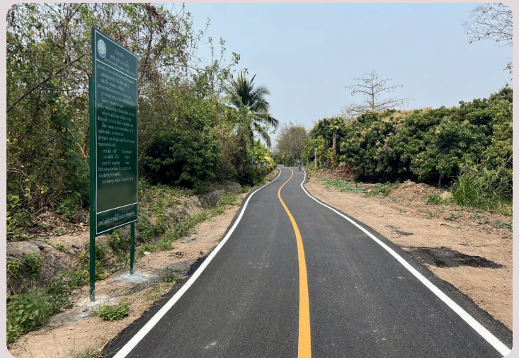
ปรับปรุงผิวจราจรแบบไอเวอร์เลย์ด้วยแอสฟัลติกคอนกรีต บ้านห้วยอีแต หมู่ที่ 13
