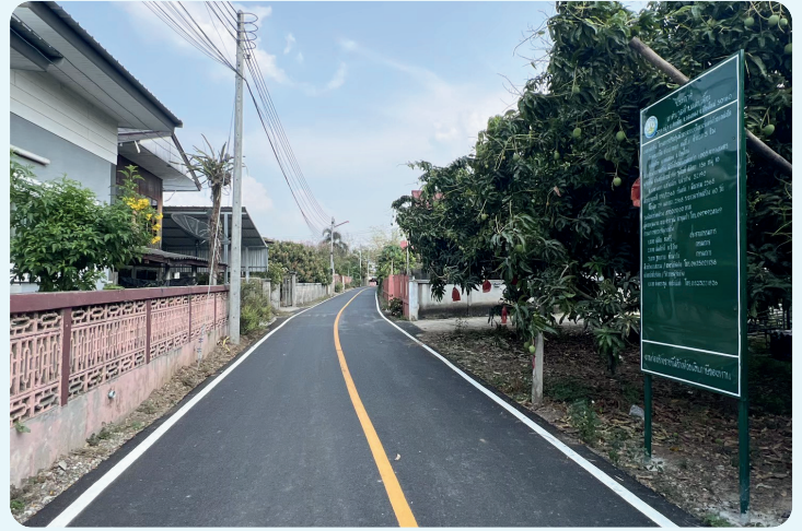
ปรับปรุงผิวจราจรแบบไอเวอร์เลย์ด้วยแอสฟัลติกคอนกรีต บ้านท่าหลุก หมู่ที่ 4
