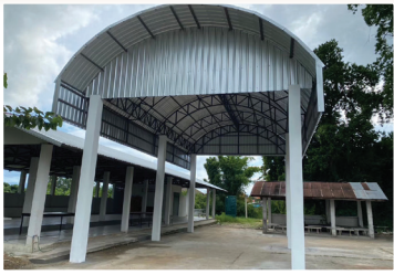
โครงการก่อสร้างอาคารอนุประสงค สุสานบ้านสบเตี๊ยะ หมู่ที่2
