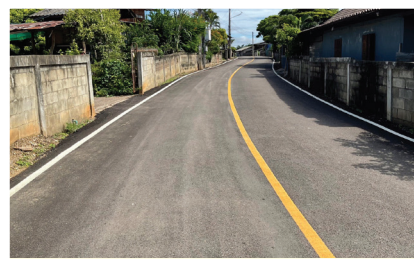
โครงการปรับปรุงผิวจราจรแบบโอเวอร์เลย์ด้วยแอสฟัลติกคอนกรีต บ้านทุ่งปูน หมู่ที่10
