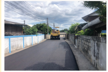
โครงการปรับปรุงผิวจราจรแบบโอเวอร์เลย์ ด้วยแอสฟัลติกคอนกรีต บ้านสบเตี๊ยะ หมู่ที่2
