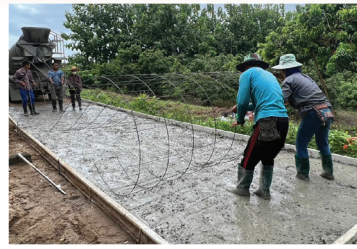
โครงการจ้างเหมาก่อสร้างถนนคอนกรีต เสริมเหล็กบ้านวังปาน หมู่ที่12
