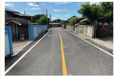
โครงการปรับปรุงผิวจราจรแบบโอเวอร์เลย์ด้วยแอสฟัลติกคอนกรีต บ้านทุ่งปูน หมู่ที่10
